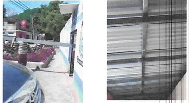
1. cambio de lamina debido que esas estan deterioradas, oxidada y corrhidas lado afuer y en invierno se entra el agua.
