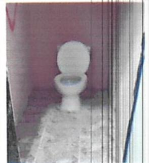
6. Levantamiento de piso de granito, compactacion de terreno y aplicado de concreto para posterior colocar piso ceramico. 7. Cambio de sanitario y reparacion de drenaje.
